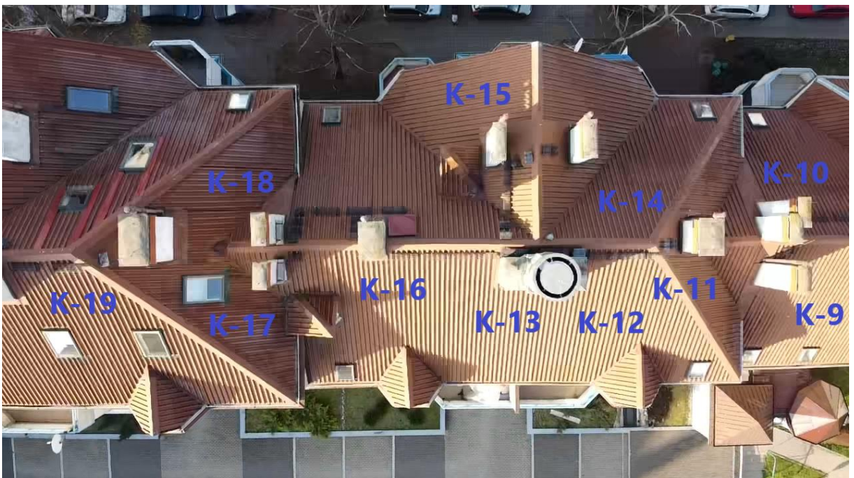
Zdj. 5. Rzut połaci dachowej z przyjętą numeracją kominów, cz. 2 z 11.
