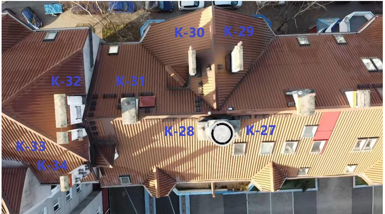
Zdj. 7. Rzut połaci dachowej z przyjętą numeracją kominów, cz. 4 z 11.
