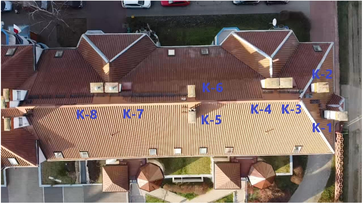
Zdj. 4. Rzut połaci dachowej z przyjętą numeracją kominów, cz. 1 z 11.
