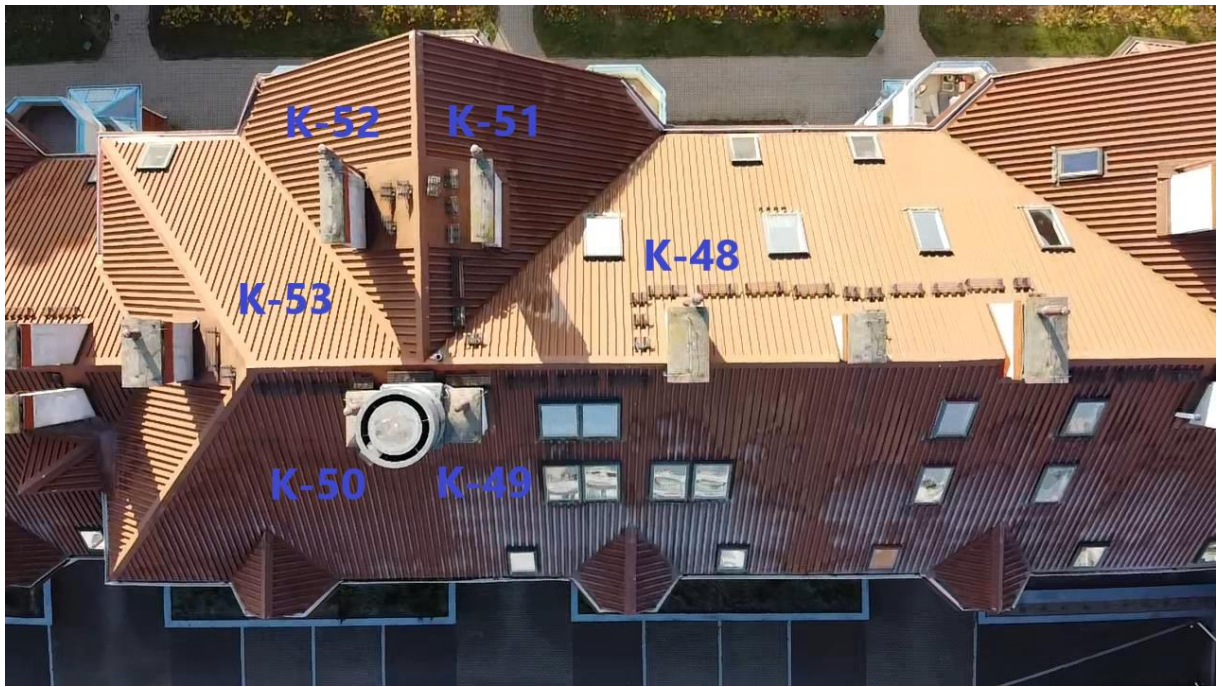
Zdj. 10. Rzut połaci dachowej z przyjętą numeracją kominów, cz. 7 z 11.
