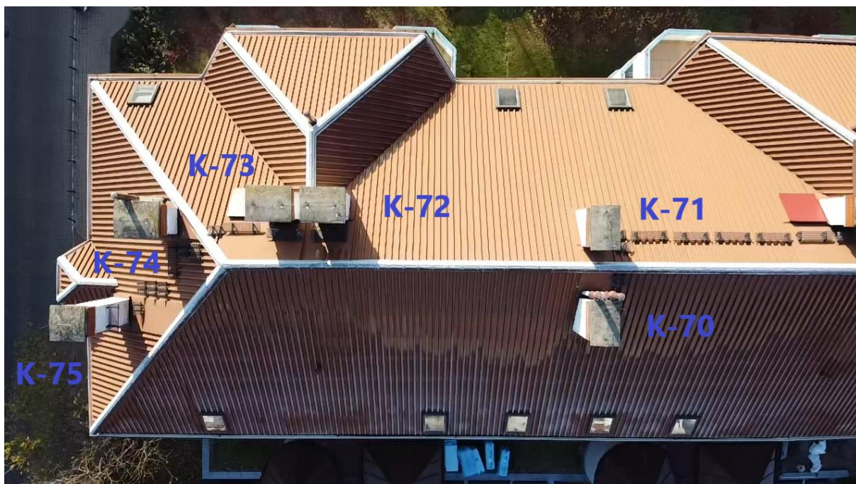
Zdj. 14. Rzut połaci dachowej z przyjętą numeracją kominów, cz. 11 z 11.
