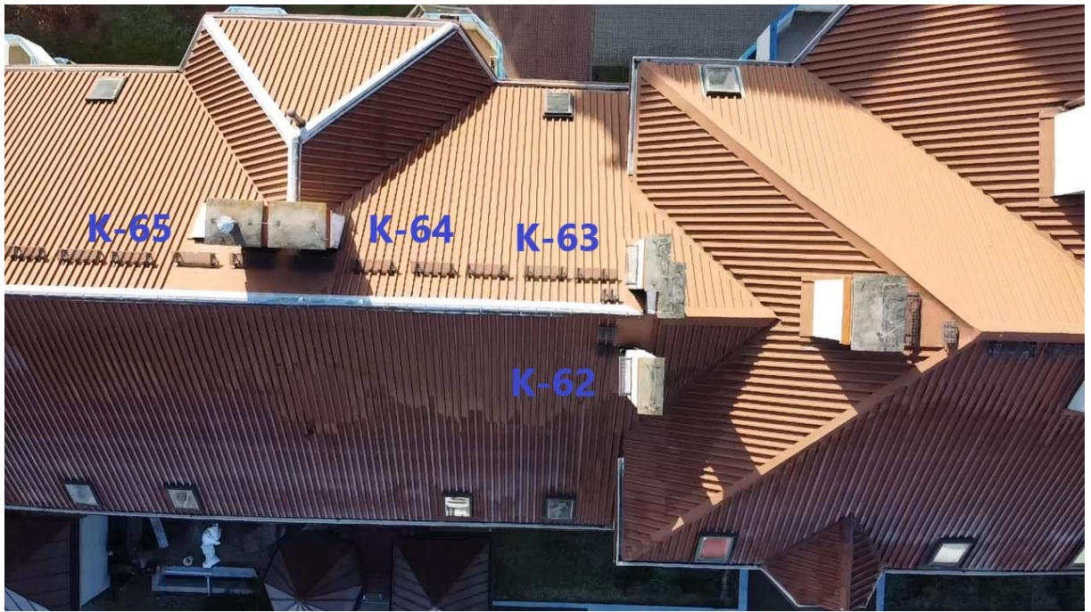
Zdj. 12. Rzut połaci dachowej z przyjętą numeracją kominów, cz. 9 z 11.
