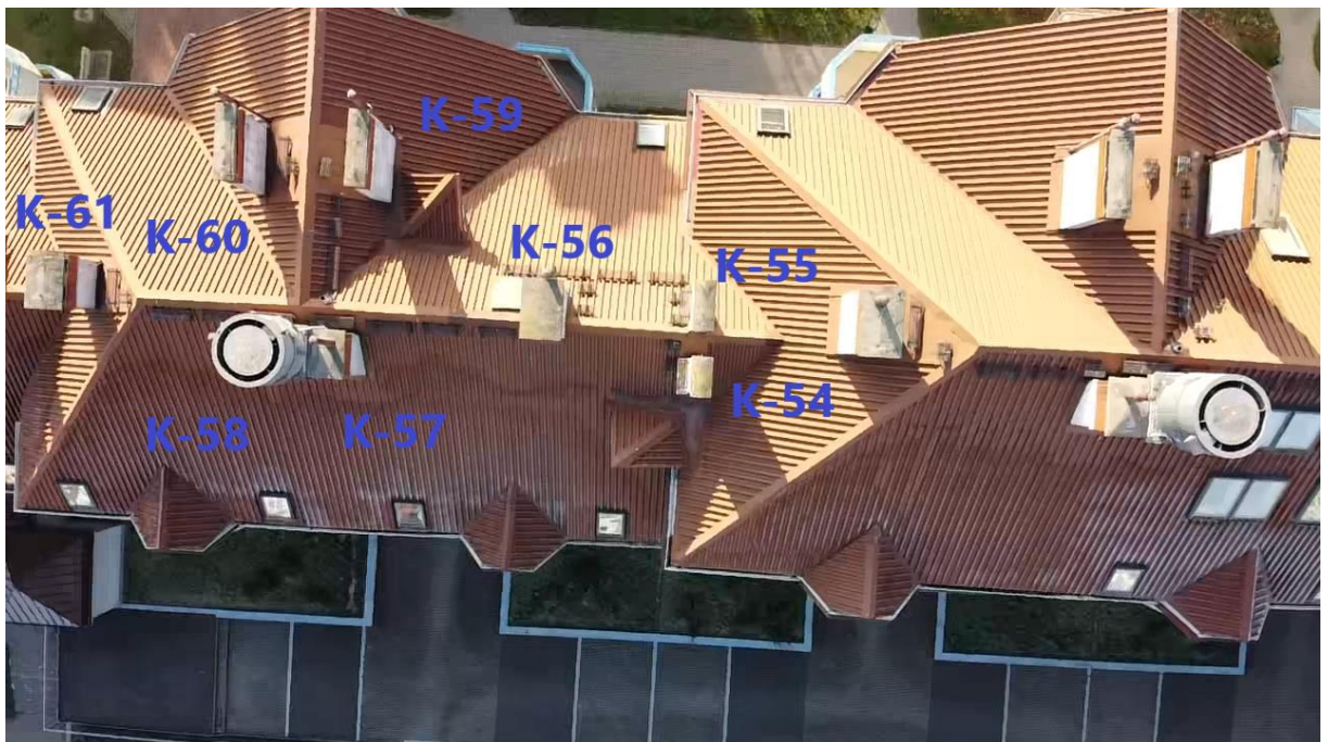
Zdj. 11. Rzut połaci dachowej z przyjętą numeracją kominów, cz. 8 z 11.
