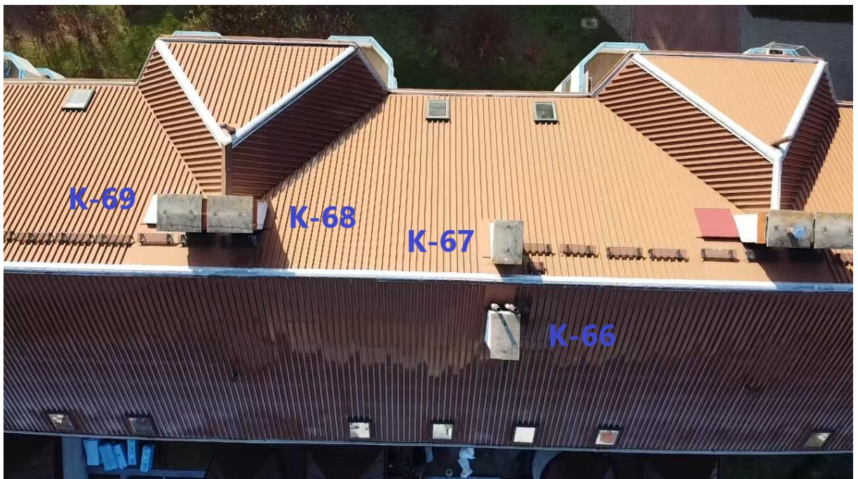
Zdj. 13. Rzut połaci dachowej z przyjętą numeracją kominów, cz. 10 z 11.
