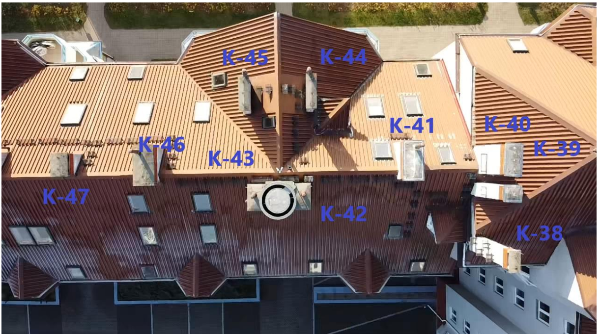
Zdj. 9. Rzut połaci dachowej z przyjętą numeracją kominów, cz. 6 z 11.
